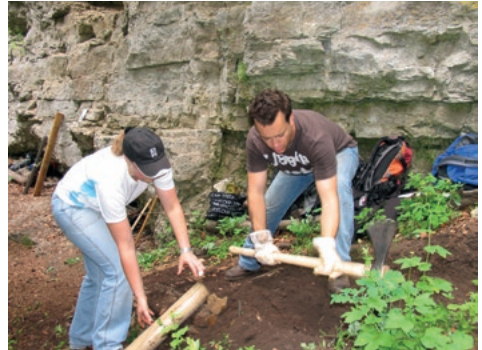
Steigsanierung zur Vermeidung von Erosionsschäden
