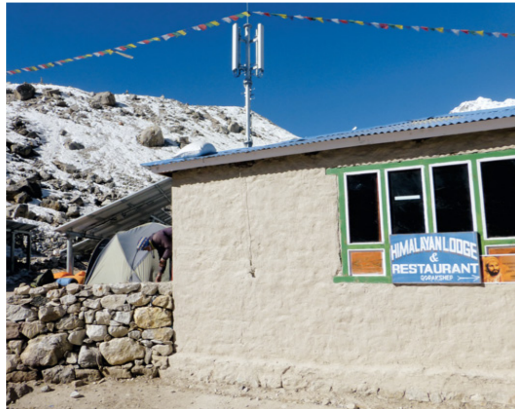
Mobilfunk-Mast in Gorak Shep unweit des Basislagers auf der Südseite des Mount Everest
